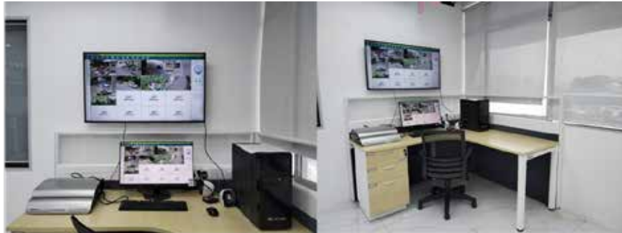
Sudut Kawalan CCTV Jabatan Pengurusan Sisa Pepejal dan Kesihatan (JPSPK), MPS
