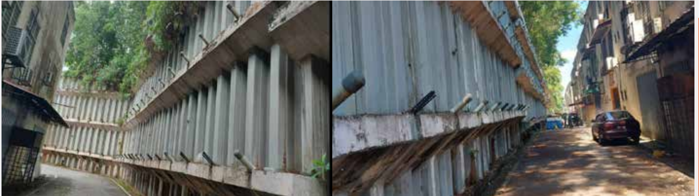
Pembaikan tanah runtuh di Apartment Teratai, Bandar Baru Selayang
