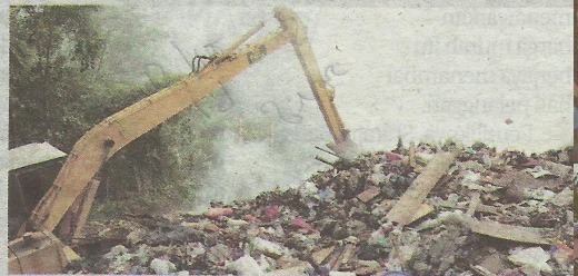
Jentera digunakan bagi mengurai sampah bagi memadamkan kebakaran di dasar timbunan sampah domestik dan sisa binaan.
