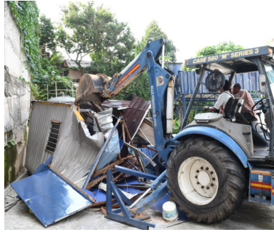
Operasi Roboh Bangunan 4 Mei 2017
